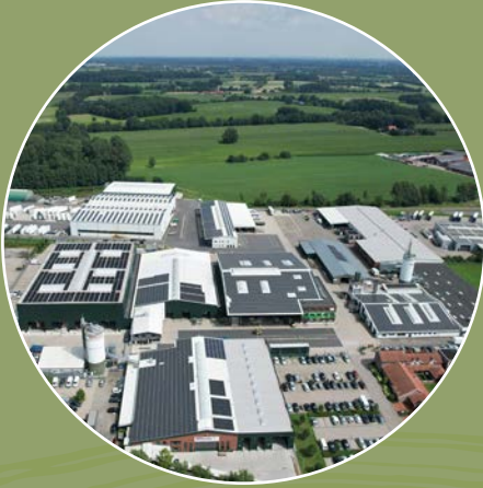
Terhalle Hauptstandort Ahaus-Ottenstein
