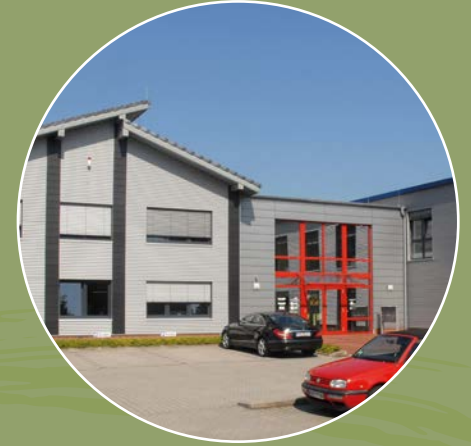
ABV Bedachung und Bautenschutz Aurich
