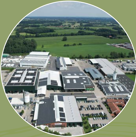
Terhalle Hauptstandort Ahaus-Ottenstein
