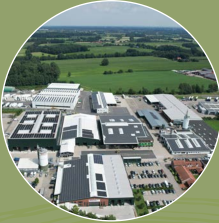
Terhalle Hauptstandort Ahaus-Ottenstein
